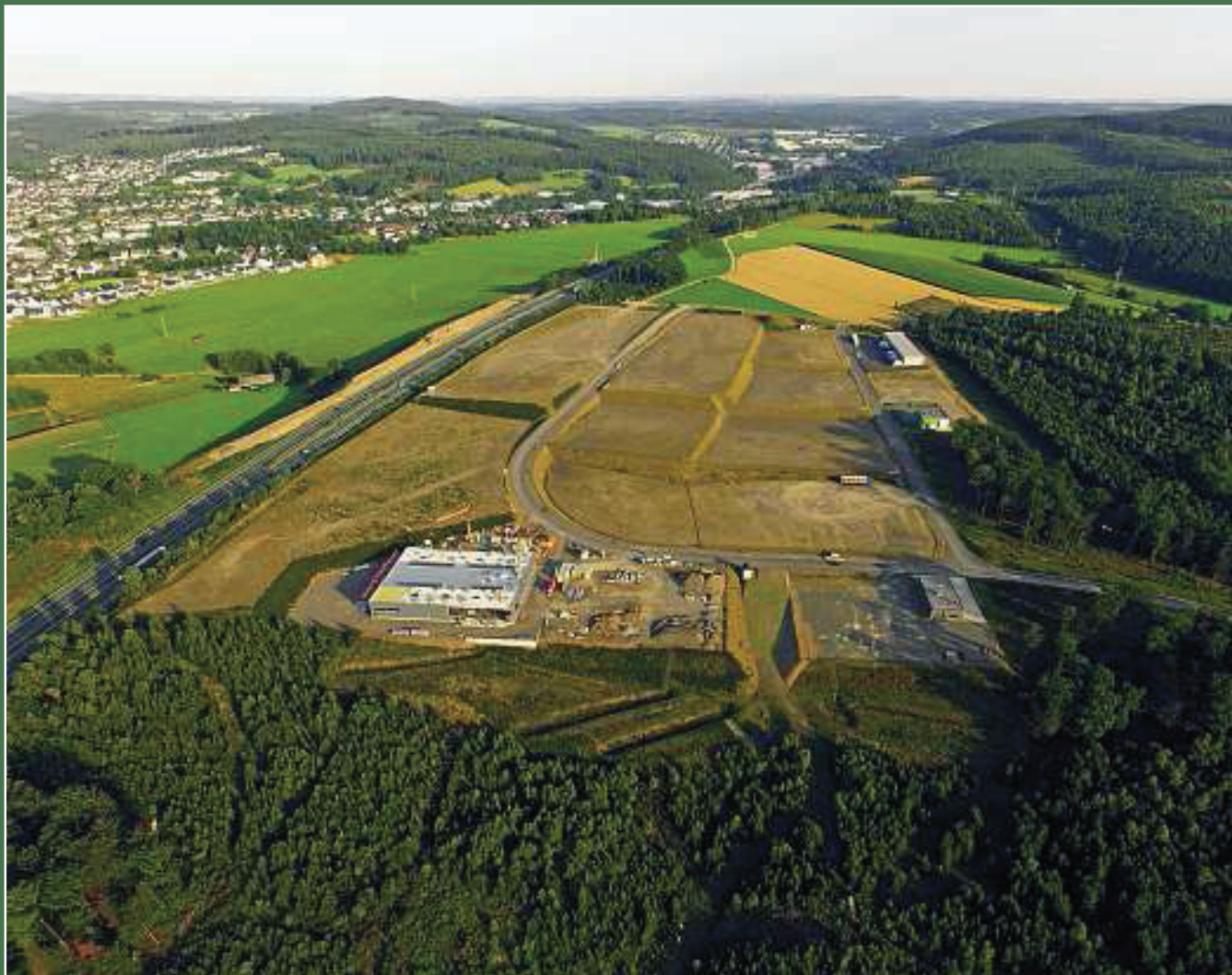
Das Gewerbegebiet Hüppcherhammer ist ein Gemeinschaftsprojekt der Kreisstadt Olpe und der Stadt Drolshagen.
